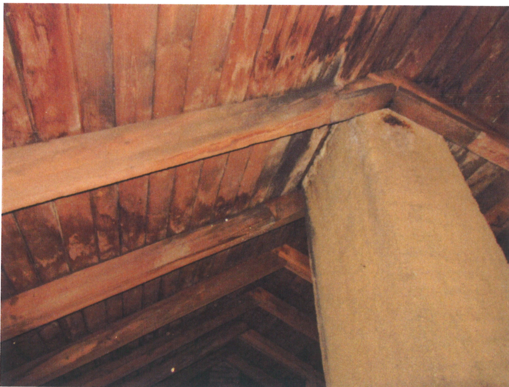
Zatékání v okolí komína, degradace povrchu dřevní hmoty
