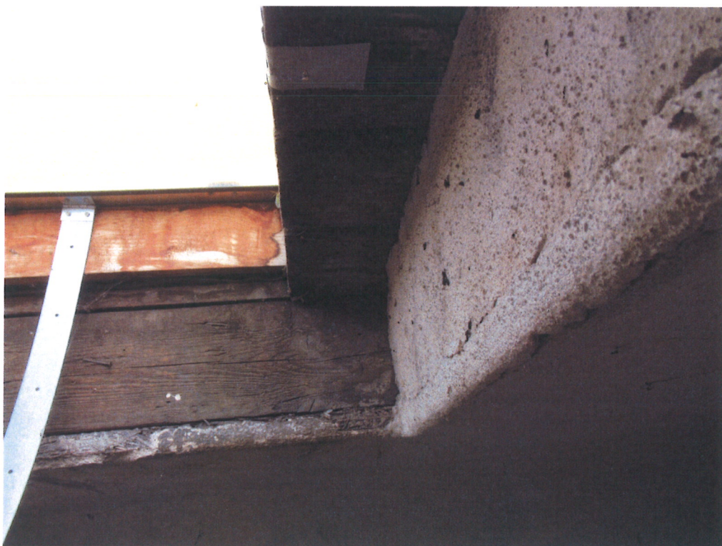
Zatékání v okolí střešního okna
