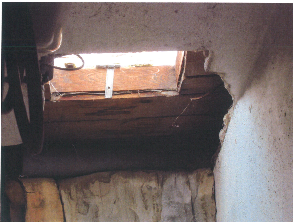
Zatékání a povrchová degradace bednění u okna
