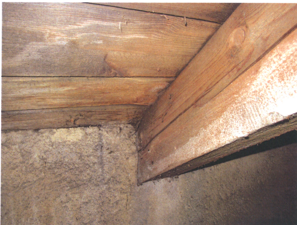
Lokální zatečení do bednění střechy
