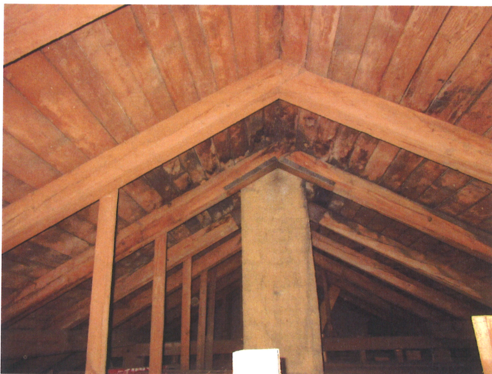
Lokální zatékání do krokví a bednění střechy
