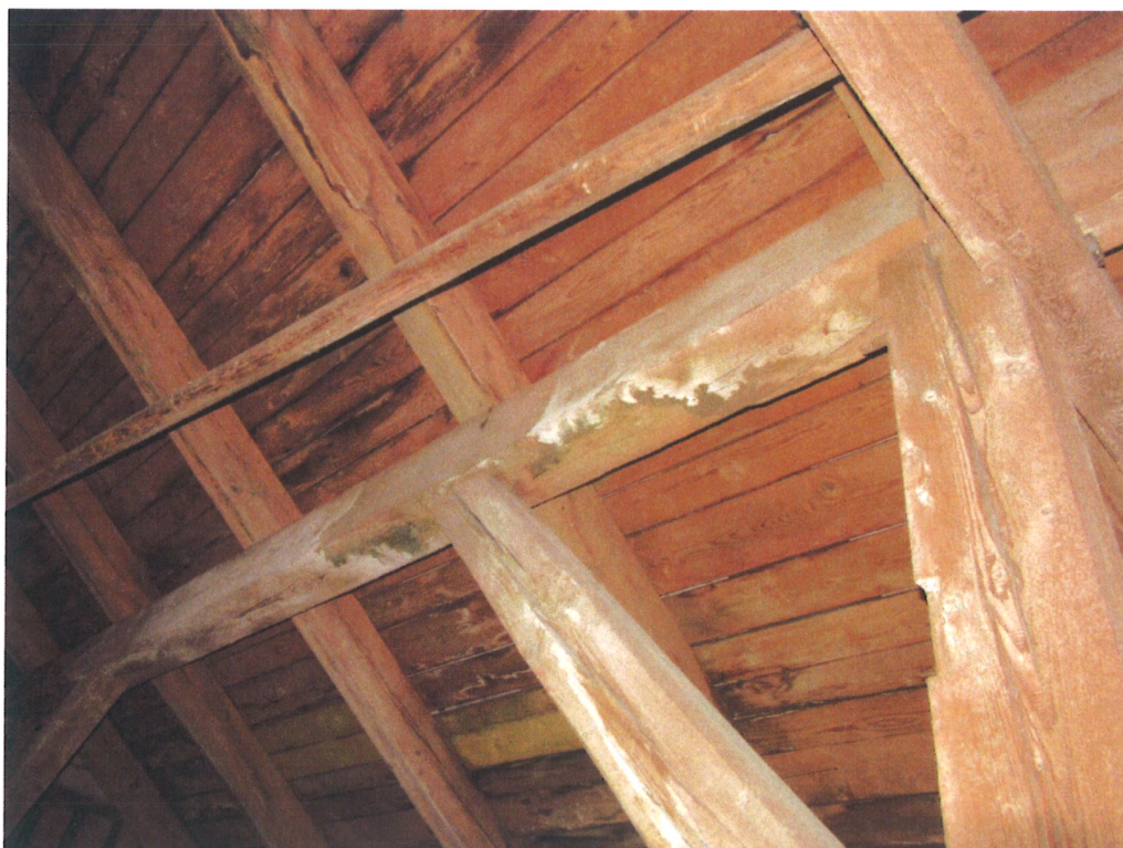
Zatékání do krokví a bednění střechy
