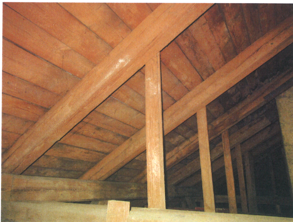
Lokální zatékání do krokví a bednění střechy
