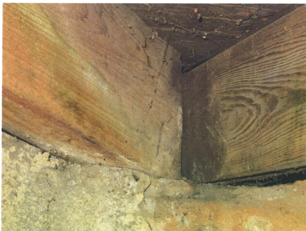
Lokální zatékání do krovu
