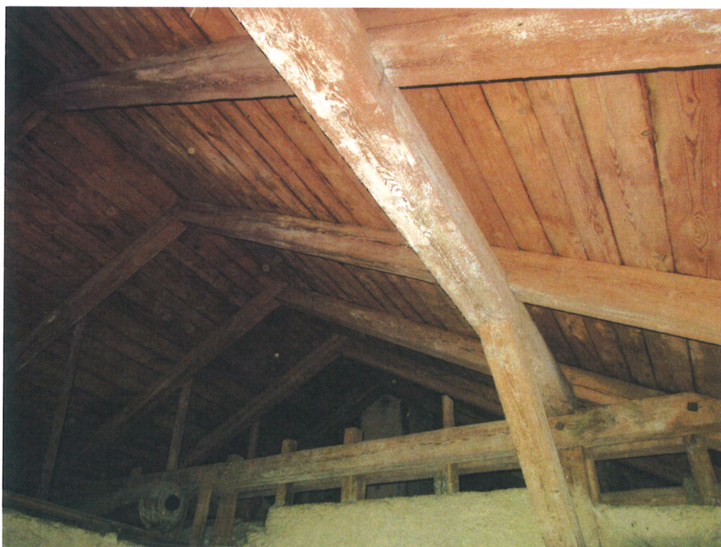
Lokální zatékání do krokví a bednění střechy
