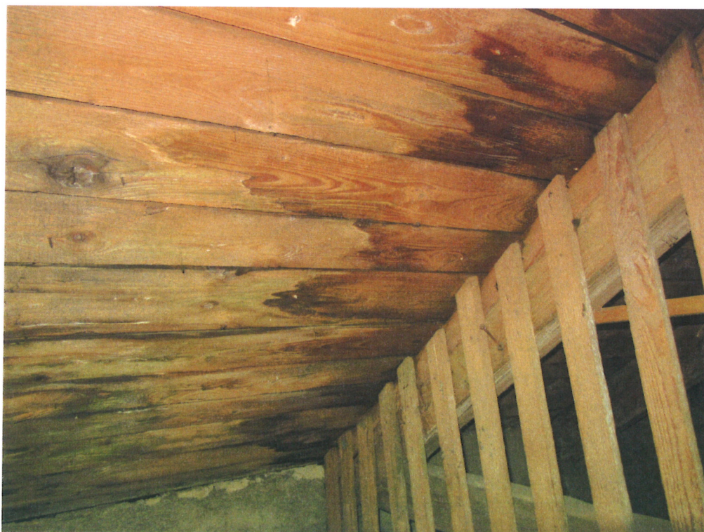
Lokální zatečení do bednění střechy
