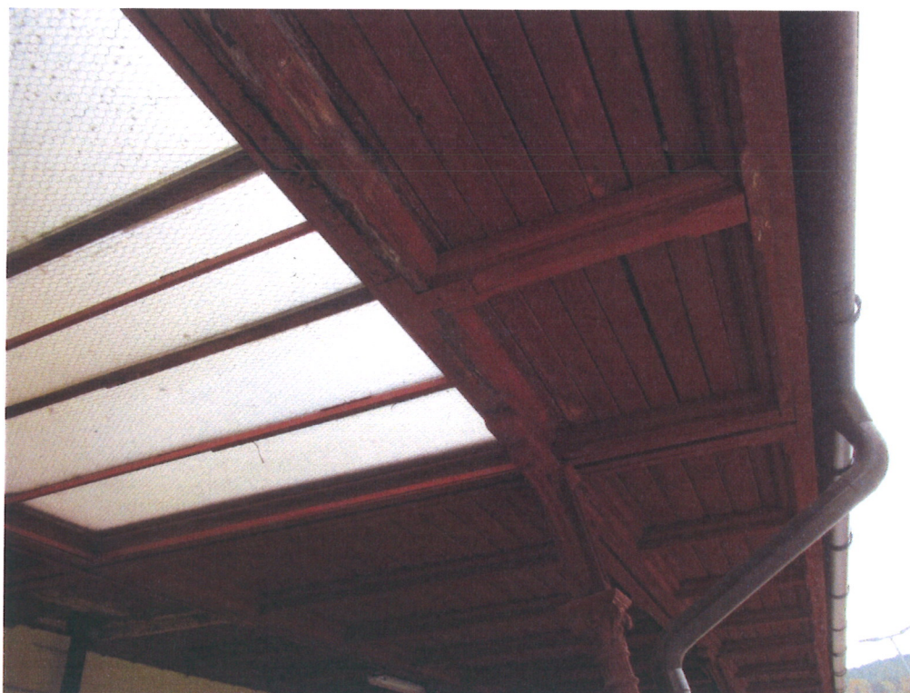
Zatékání a degradace dřevěných prvků spojů v přístřešku nástupiště
