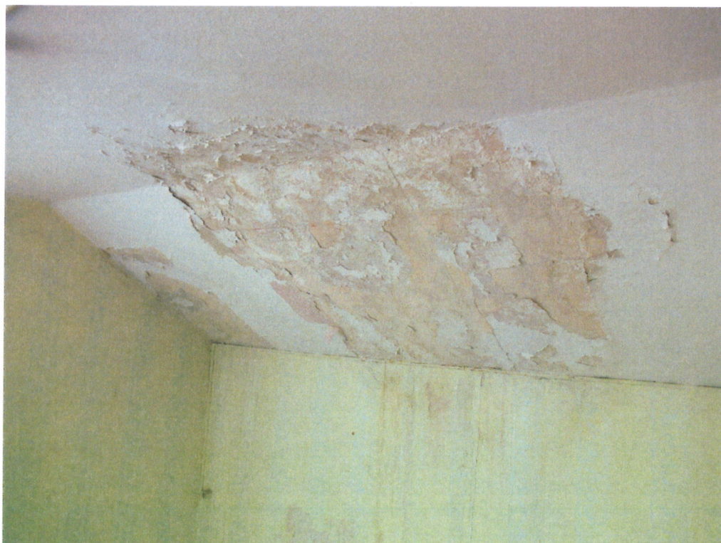
Zatékání do krovu a podhledu
