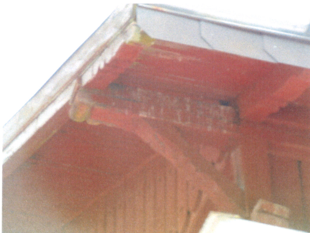
Zatékání a degradace dřevní hmoty v bednění a konzolách krokví
