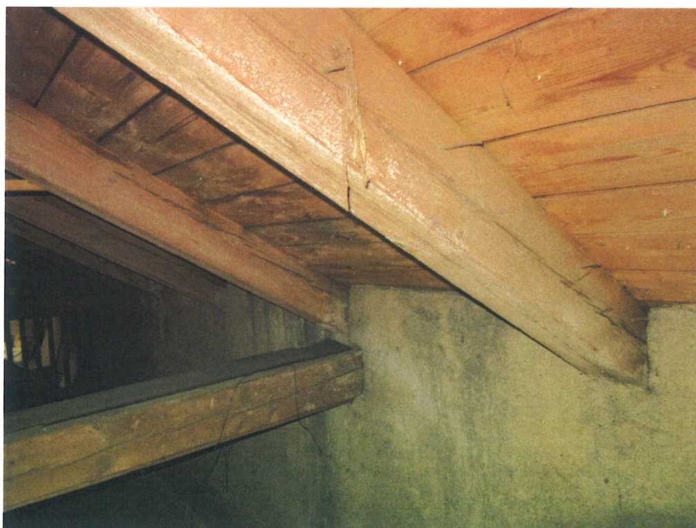
Zatékání do krokví a bednění střechy
