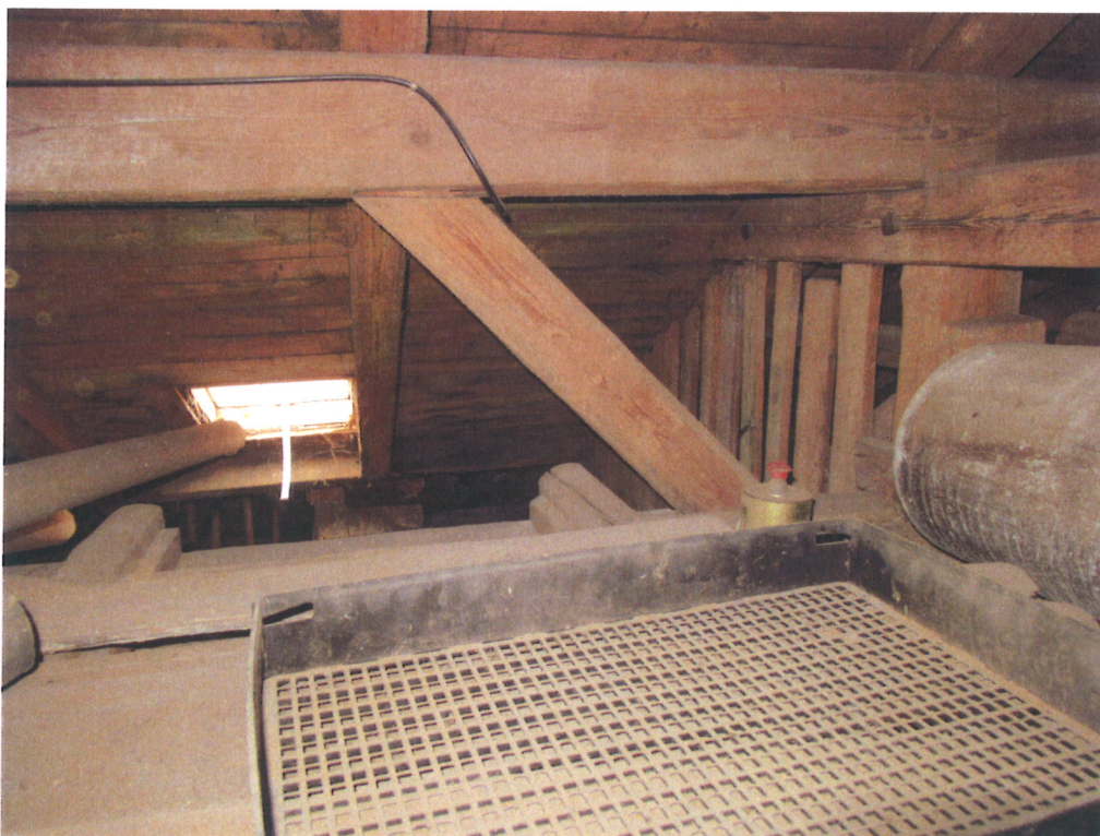
Degradace dřevní hmoty pozednice
