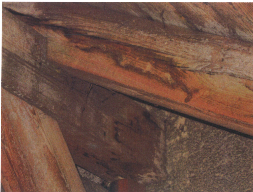
Lokální zatékání do krovu
