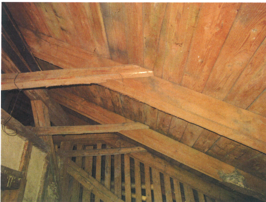
Lokální zatékání do krovu
