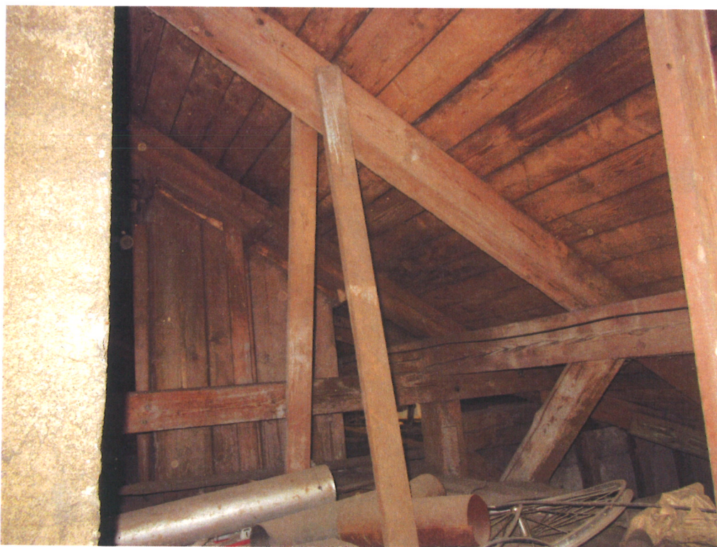
Lokální zatékání do krokví a bednění střechy
