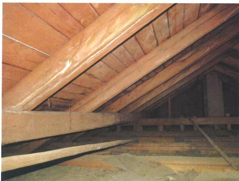
Lokální zatékání do bednění a krokví
