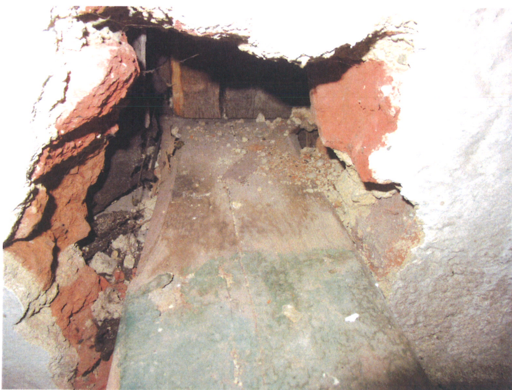
Kopaná sonda ke zhlaví vazného trámu – dřevní hmota neporušená
