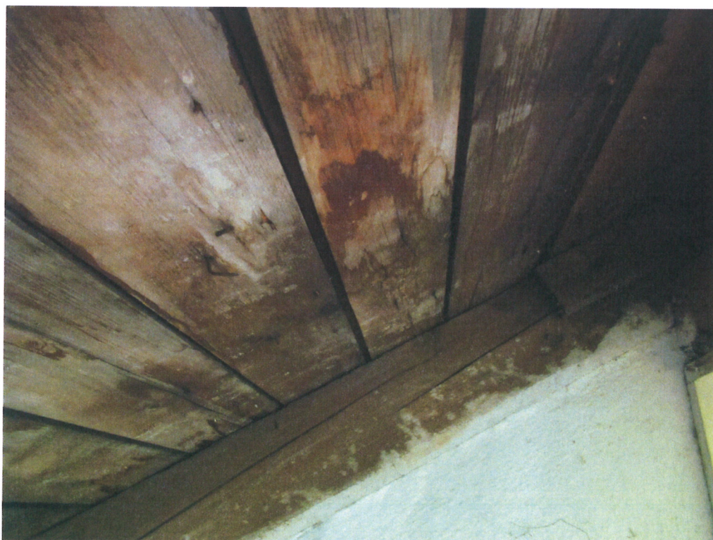
Lokální zatékání do bednění střechy, povrchová degradace dřevní hmoty
