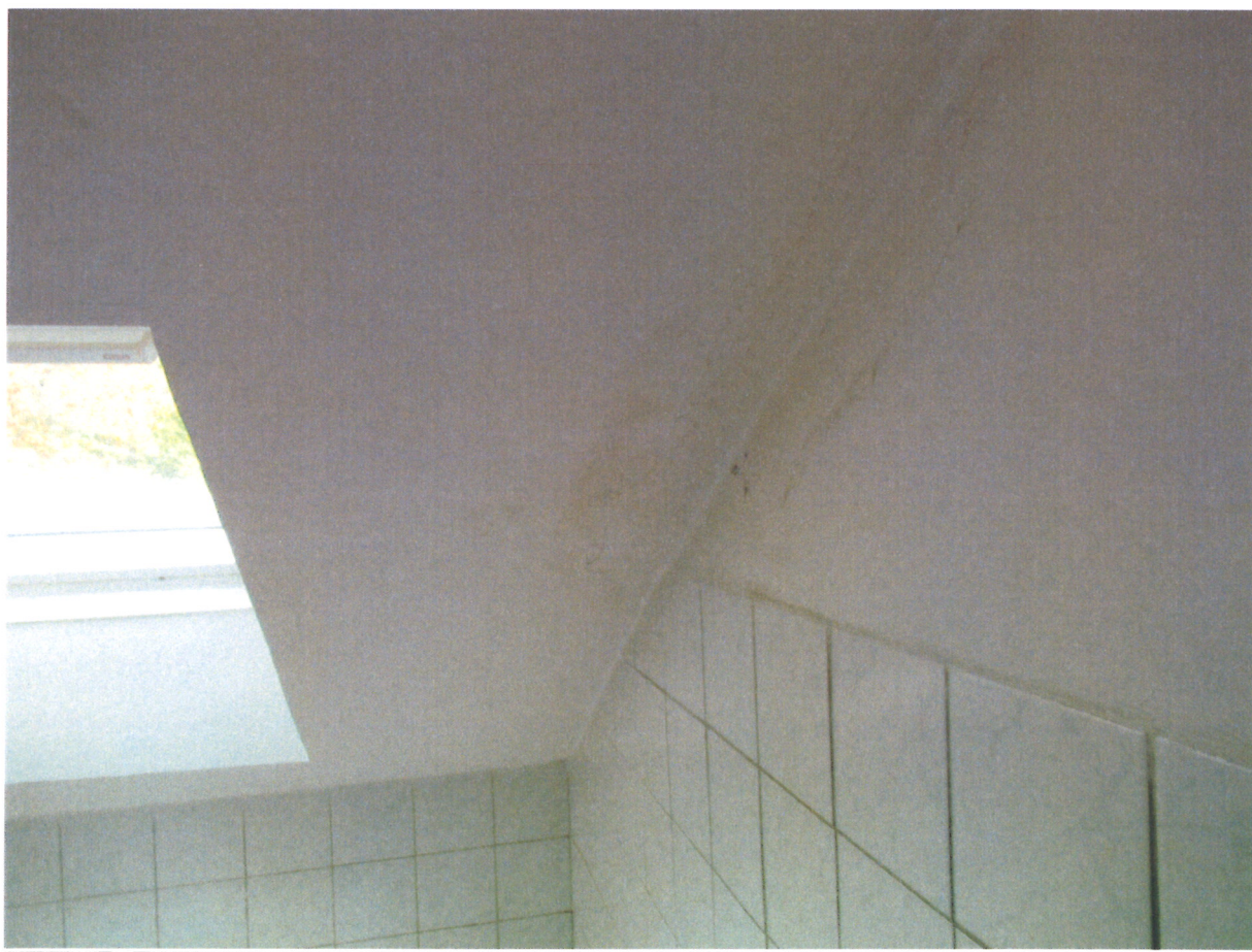
Zatékání a průsaky v podhledu
